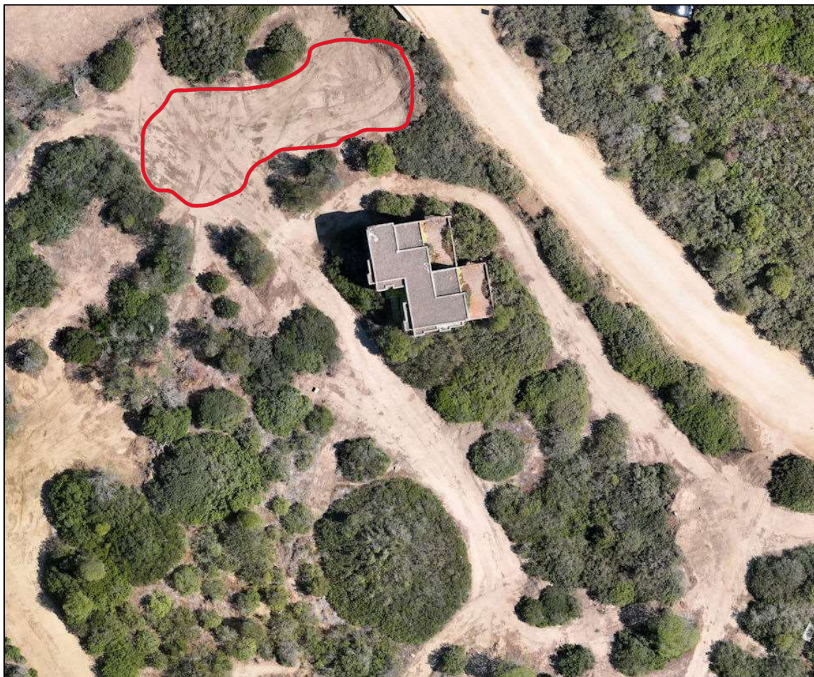
Fig. 14 – Manufatto B da demolire, in rosso la possibile area di cantiere temporaneo
