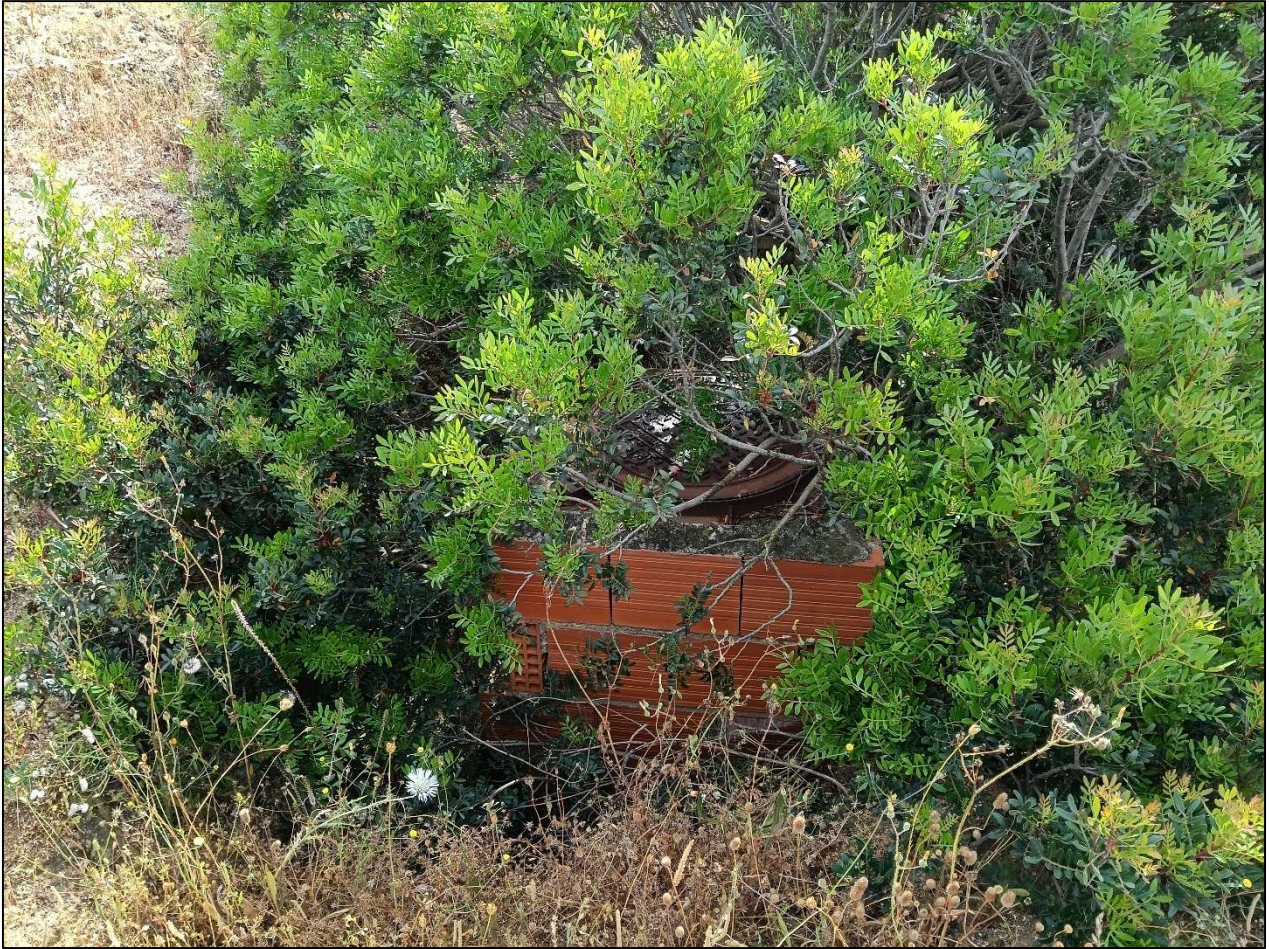
Fig. 10 – Pozzetto di Abbanoa presente nella proprietà
