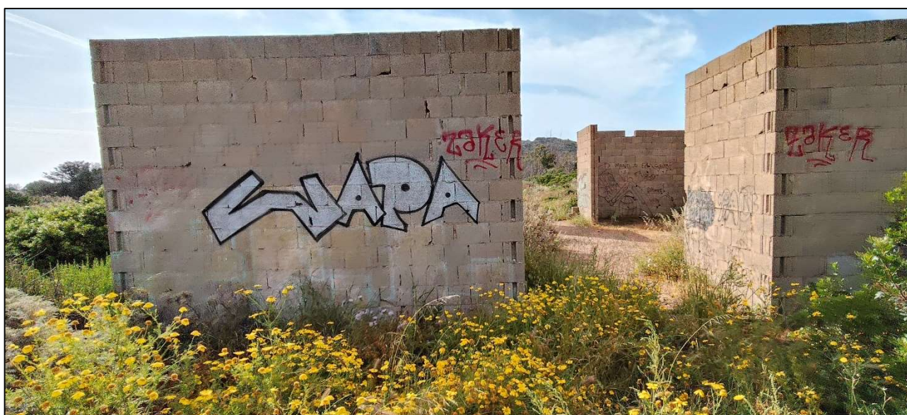
Fig. 21 – Vista frontale del manufatto
