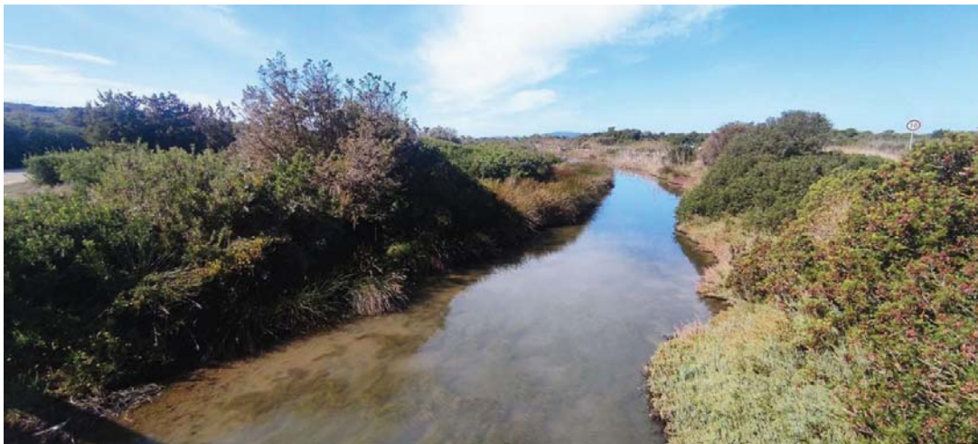
Foto 5 – Vista del canale dal ponte, verso ovest.
