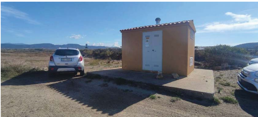
Foto 16 – Manufatto con centraline elettrica e strada di servizio per l'accesso
