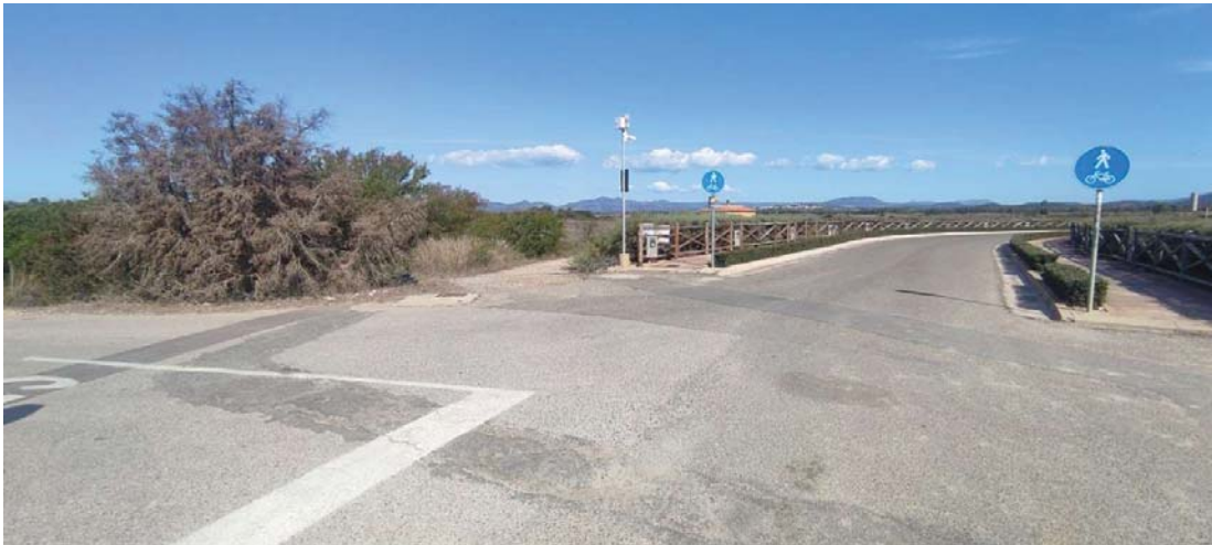
Foto 3 - Vista della viabilità esistente e dell'intersezione da sud
