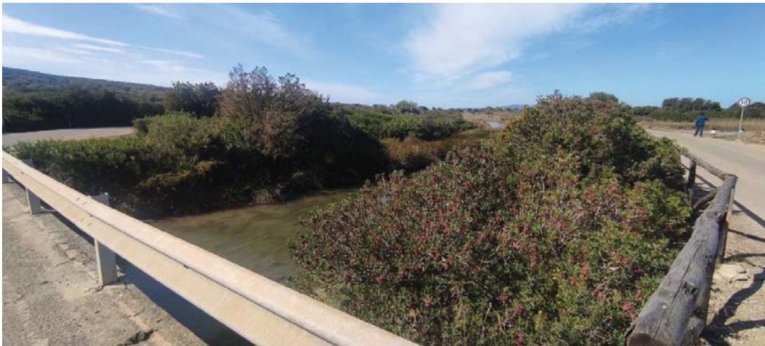
Foto 4 – Vista del ponte e della viabilità verso Is Solinas.
