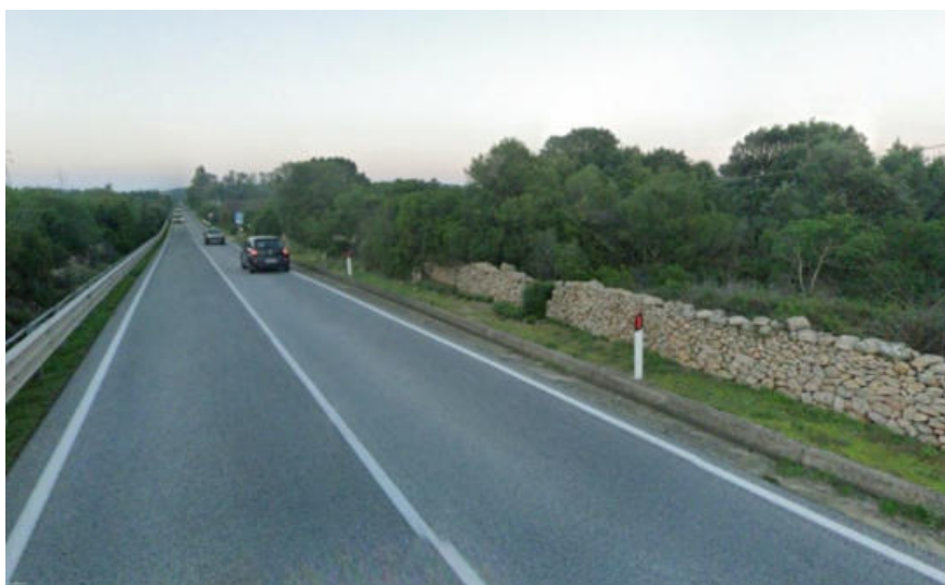
Figura 4-1 Esempio di muretto a secco situato lungo la SS 125 esistente e ad essa parallelo
