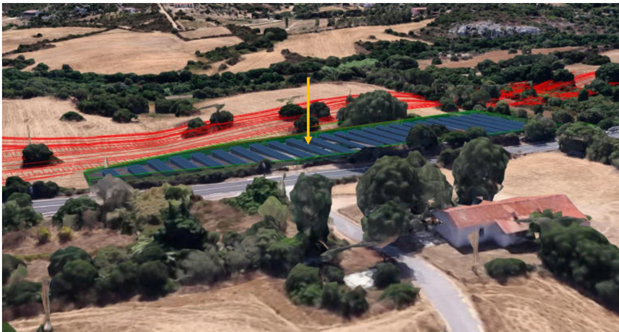
Foto 11 - Vista Aerea 2 dell'impianto
