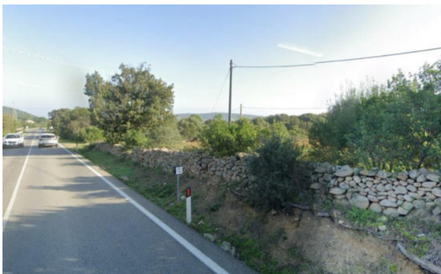
Figura 4-6 Muretto a secco tipicamente presente nell’area di studio
