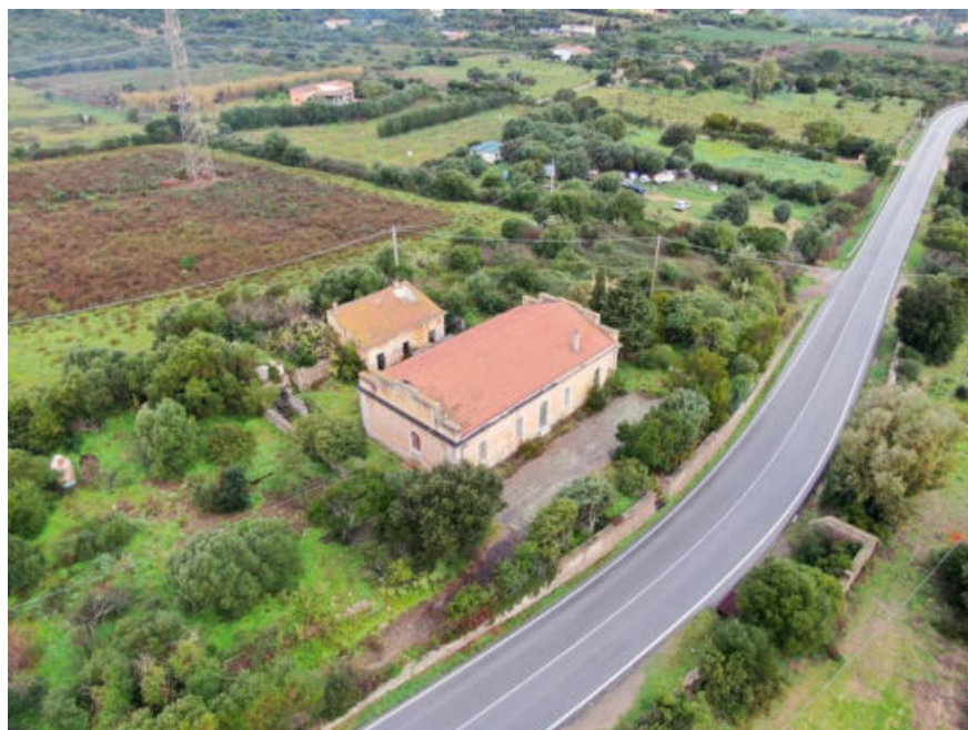
Foto 9 – La ripresa fotografica documenta la struttura insediativa del contesto rurale nei pressi dell’impianto FV03 – Trattasi di manufatti agricoli sparsi spesso dismessi, e in qualche caso convertiti ad uso turistico-ricettivo
