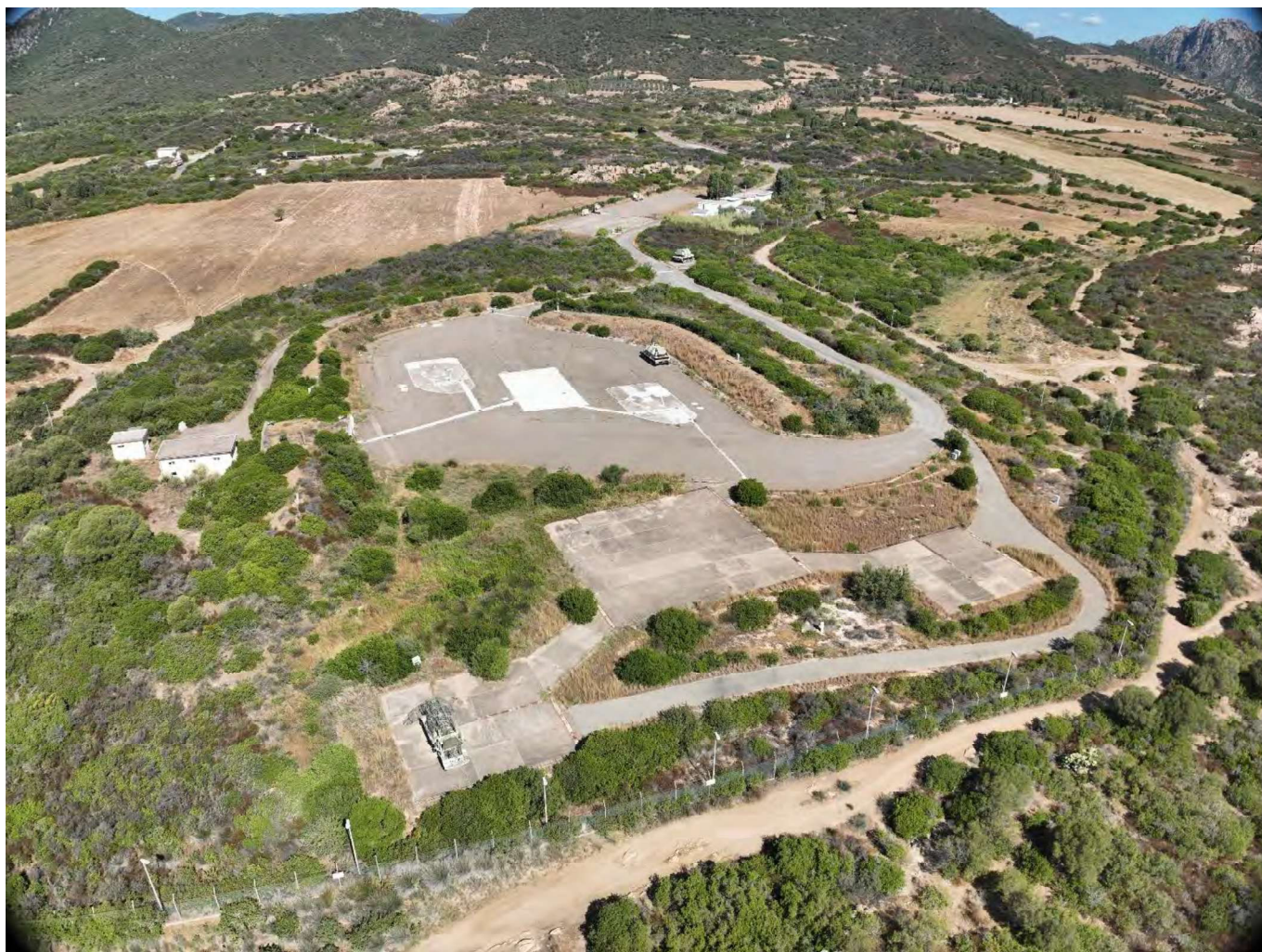
Figura 3: Zona di posizionamento degli elementi costituenti Impianti e Lanciatore vista da Est
