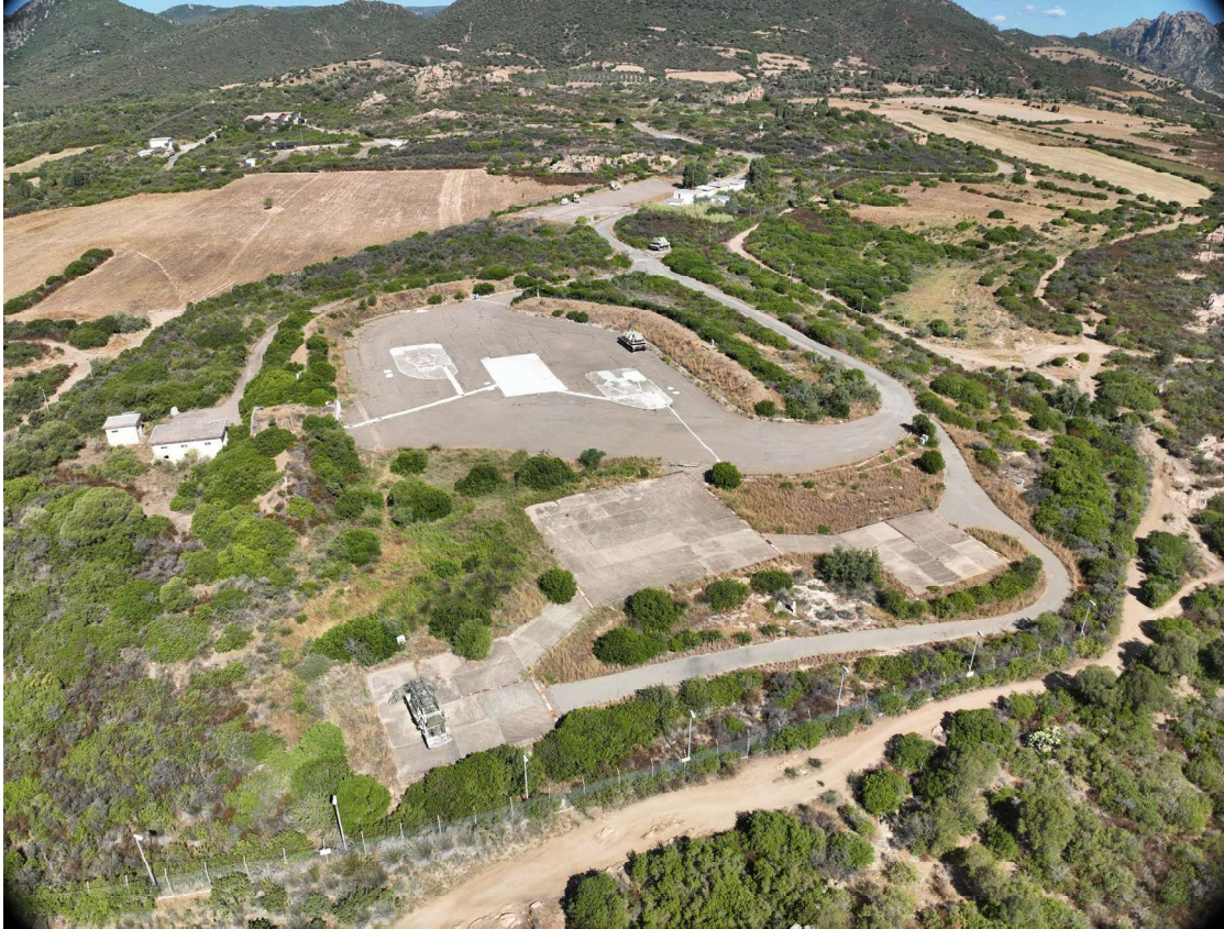
Figura 5 - Zona di posizionamento degli elementi costituenti Impianti e Lanciatore vista da Est
