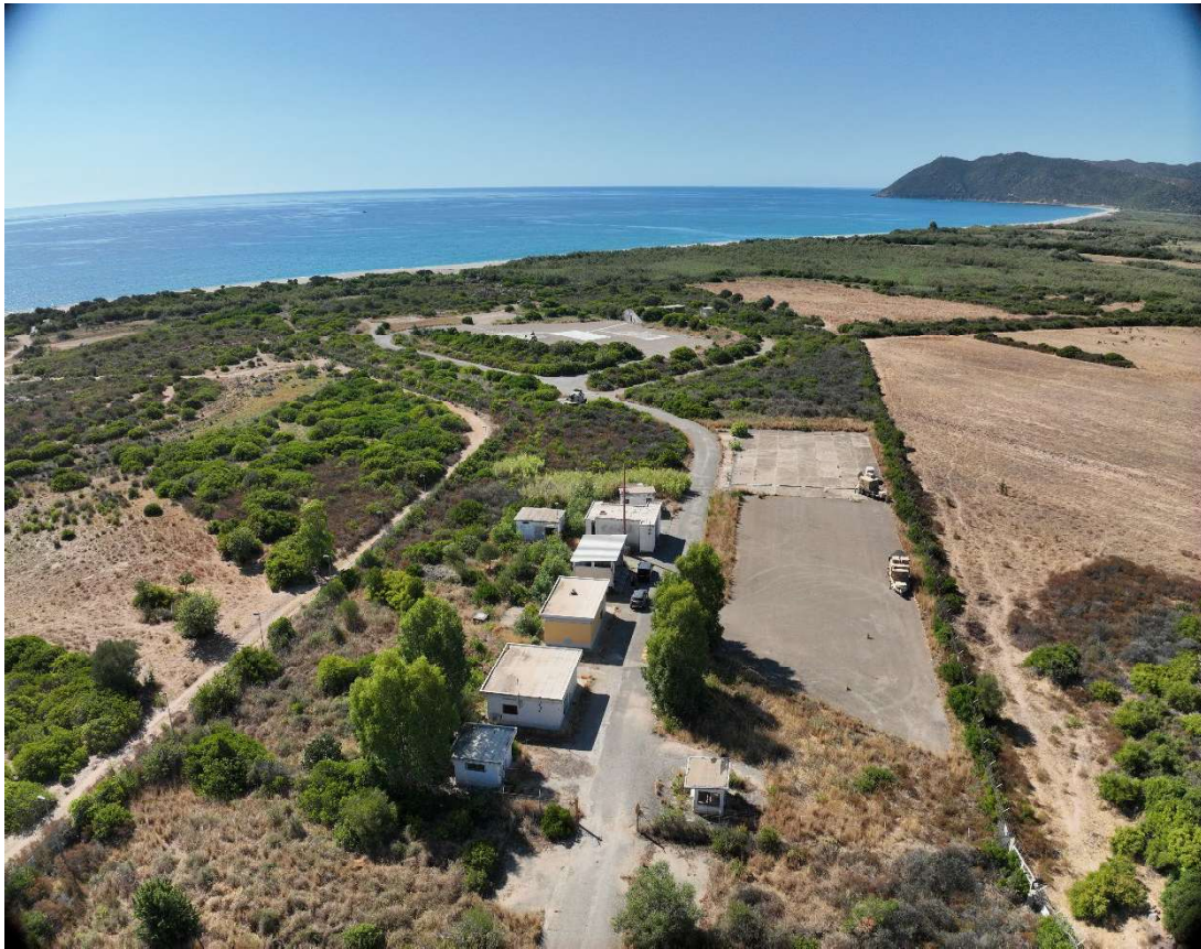
Figura 3 - Zona ampia comprendente anche l'Area di Comando e Controllo
