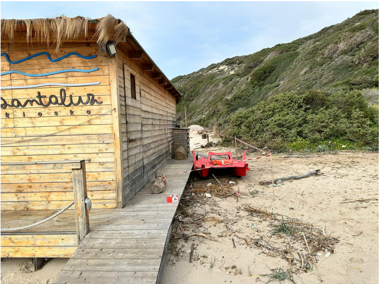
Fig. 28: Area ampliamento struttura
