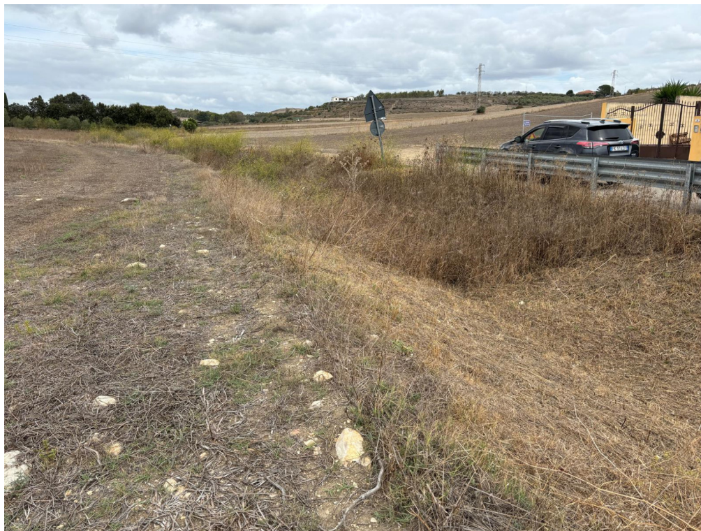
Figura 6 – Rio Tramamma. Vista verso monte dall'imbocco in via Giovanni XXIII
