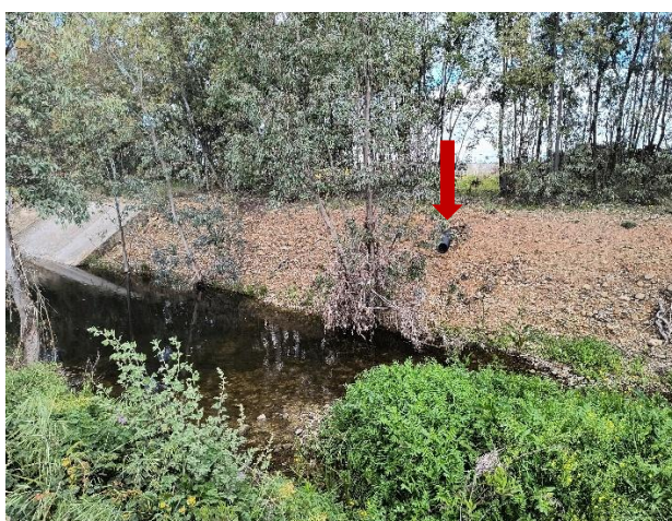
Figura 5 - ubicazione p.to di scarico vista da strada
