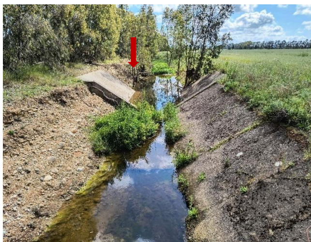
Figura 4 ubicazione p.to di scarico vista da ponte
