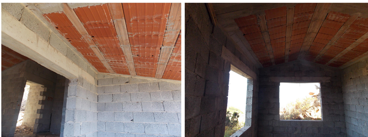
Figura 24. Visuale dell'interno dell'unità abitativa. L'accertamento ha consentito di escludere la presenza di chiroteri.
