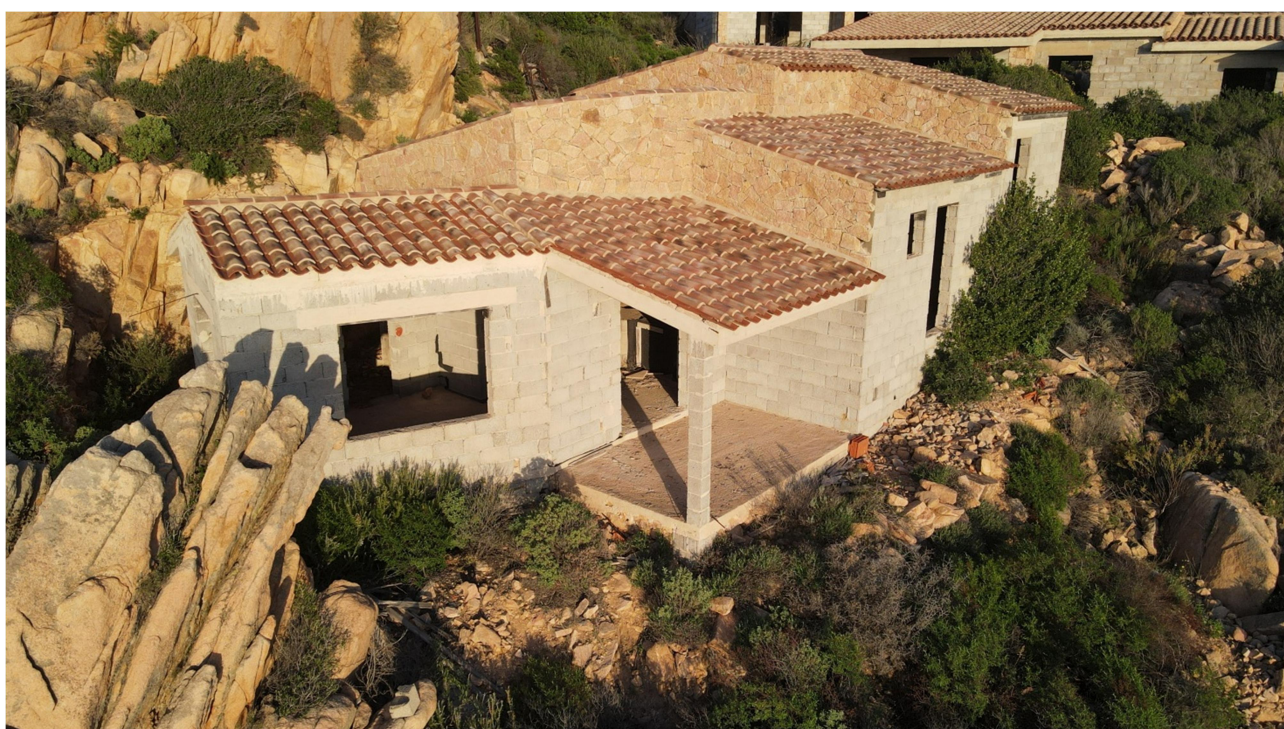
Figura 4. Immagini da drone (zenitale e prospettiva SO-NE) della proprietà oggetto di intervento con rappresentazione dello stato attuale dell’unità abitativa esistente e dell’immediato intorno.
