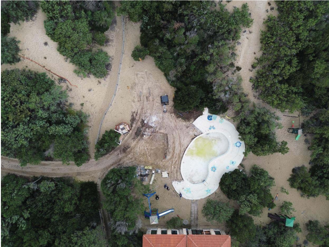
Figura 12: altra vista da drone
