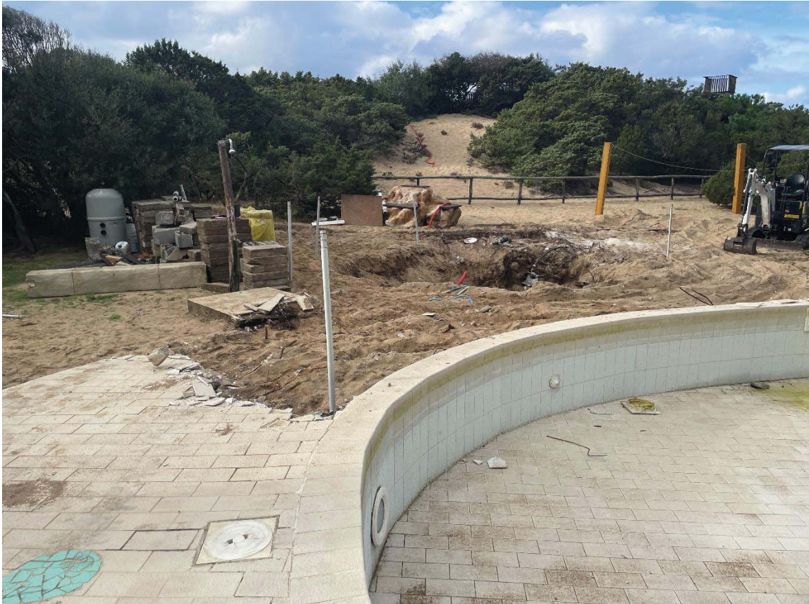
Figura 13: vista sulla zona di ampliamento piscina
