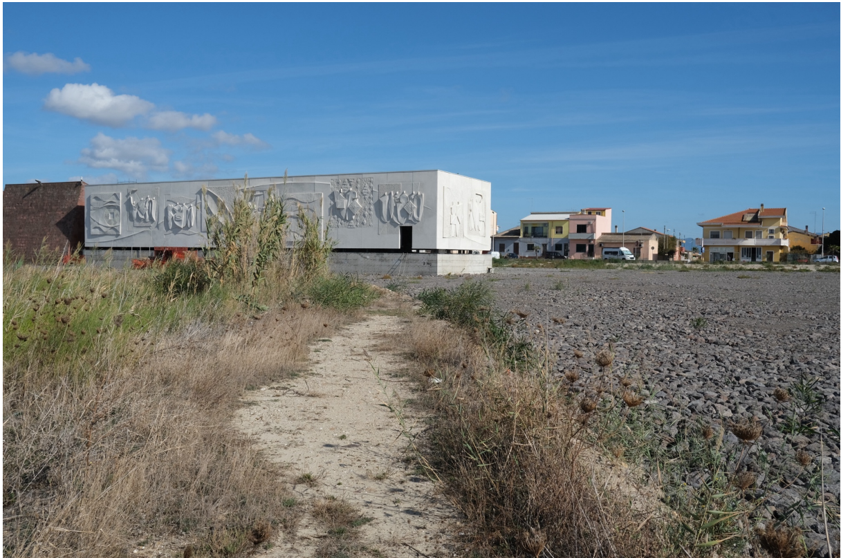
Foto della superficie oggetto della finitura superficiale a calcestruzzo
