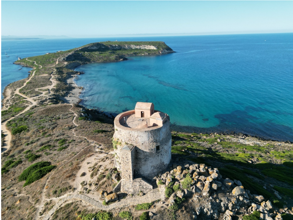
Figura 28 – Foto panoramica dal drone del Capo S. Marco e della Torre di San Giovanni di Sinis
